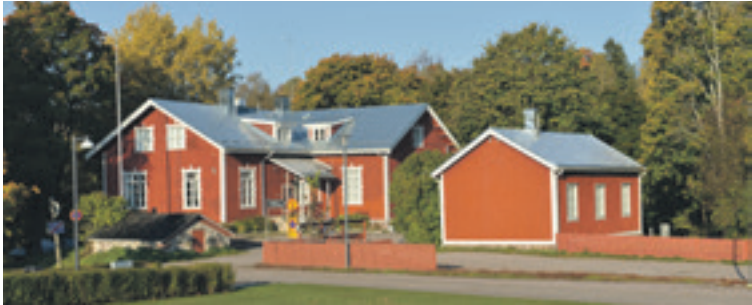
Lagstad hembygdsgård sijaitsee Espoon tuomiokirkon eteläpuolella. Kuva: Tommi Heinonen
